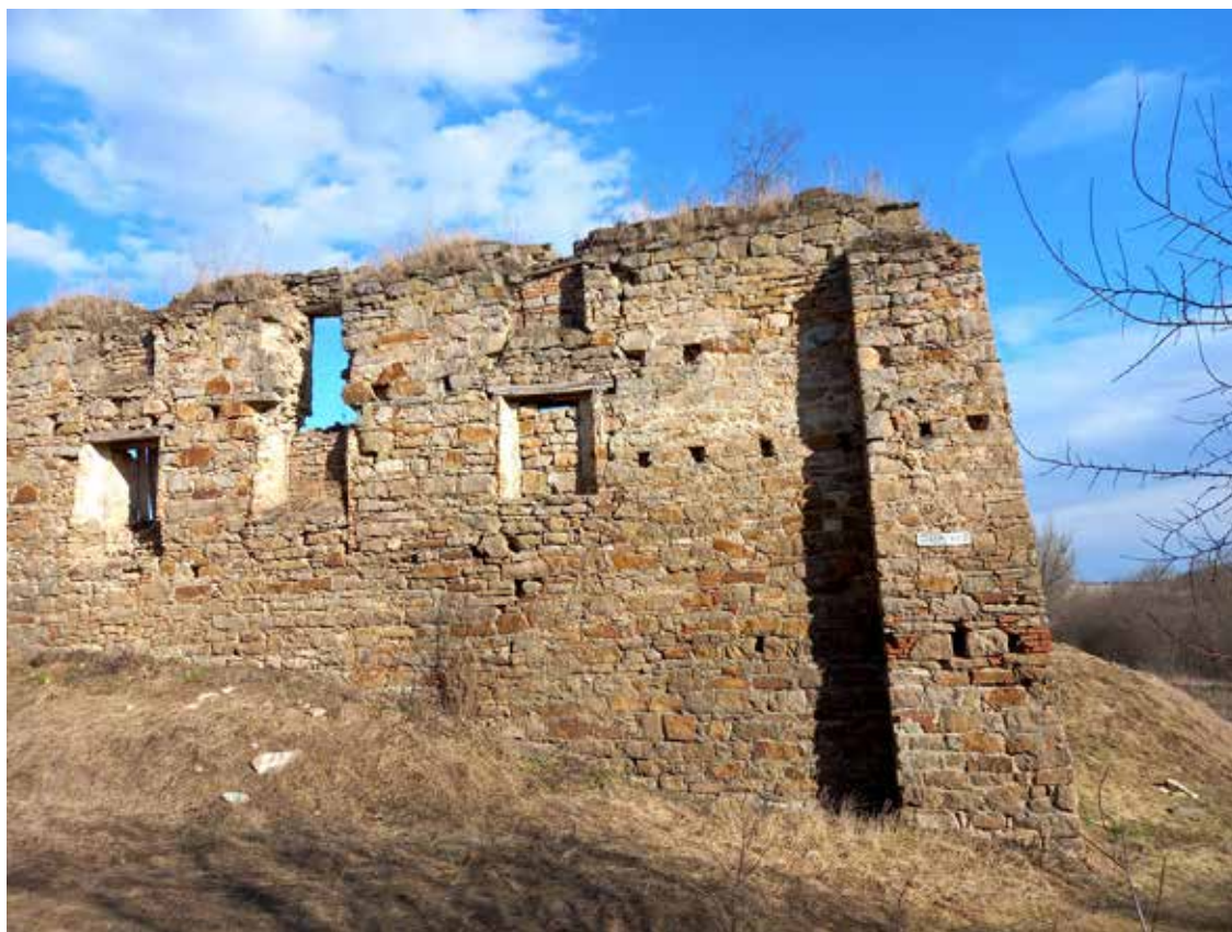
Рис. 4. Ніші для кріплення дерев'яних риштувань на стіні та південно-західному контрфорсі, свідчить про одночасність їх зведення
