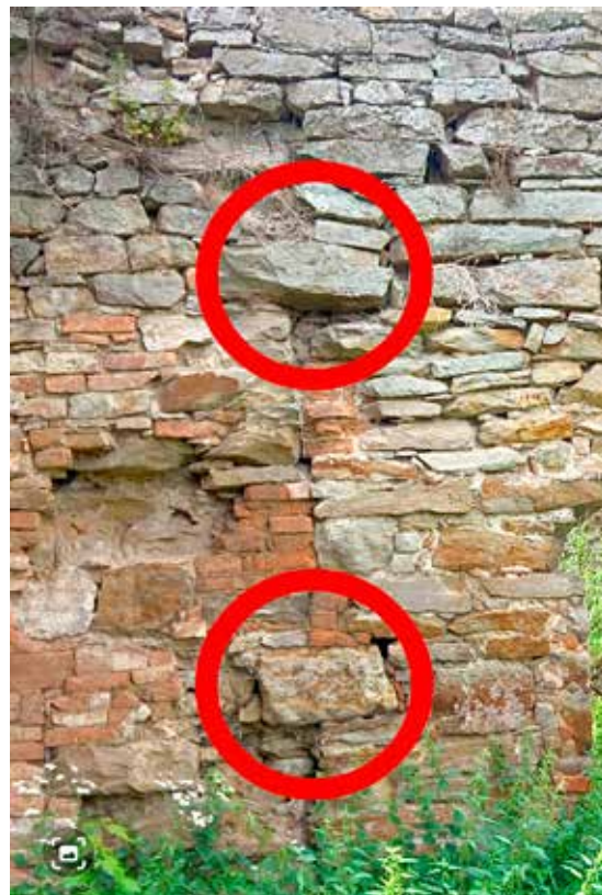
Рис. 3. Замок в Микулинцях. З'єднання старої і нової стіни за допомогою кам'яних вкладок, які надавали конструкції жорсткості
