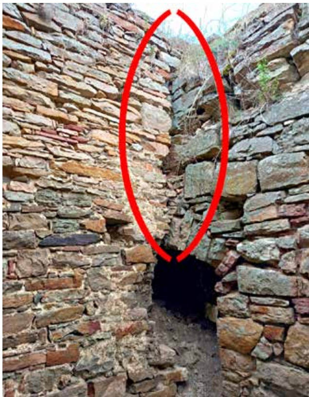
Рис. 2. Приклад недбалого пізнішого примуровування внутрішньої стіни в Микулинецького замку
