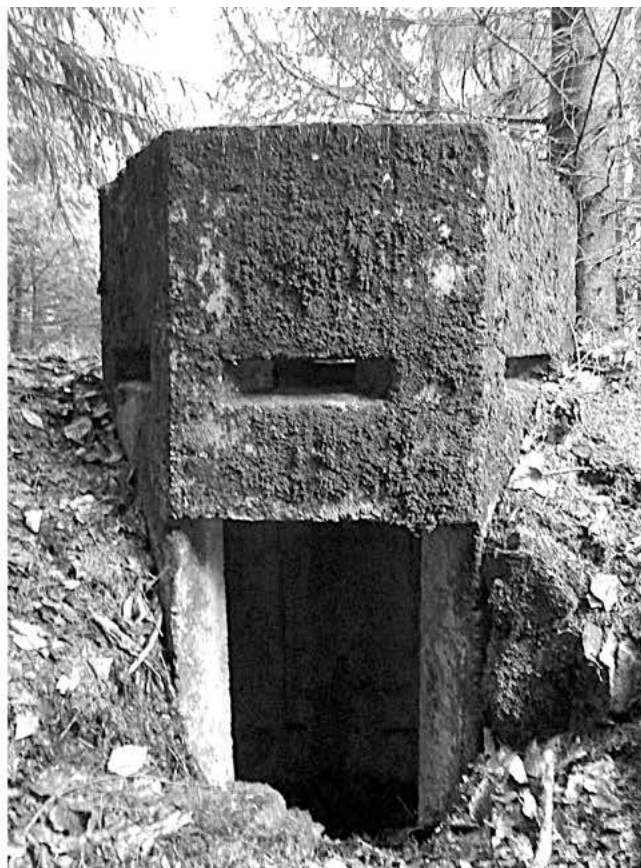
Фото 12. Залізобетонний спостережний пункт у Русько-Мокринському вузлі оборони (фотографія Максима Юценка, м. Київ).
