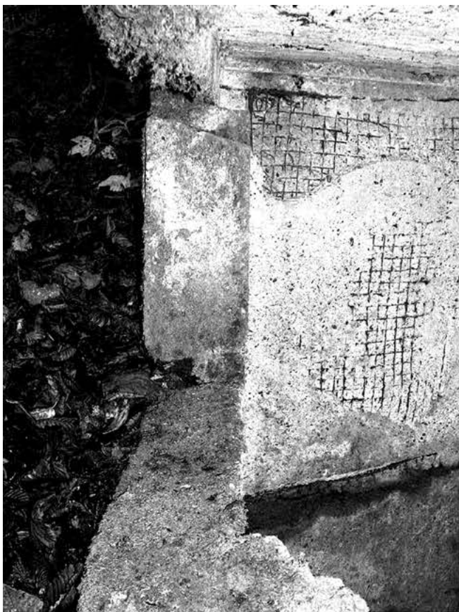
Фото 10. Пази для кріплення додаткових конструктивних елементів.
