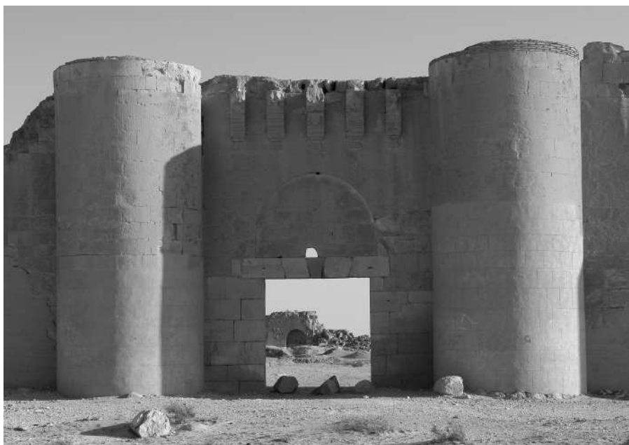
Илл. 1. Северные ворота большого сооружения в Каср аль-Хайр аль-Шарки. Видны консоли от машикуля-бретеша. Фотография К.С. Носова.
