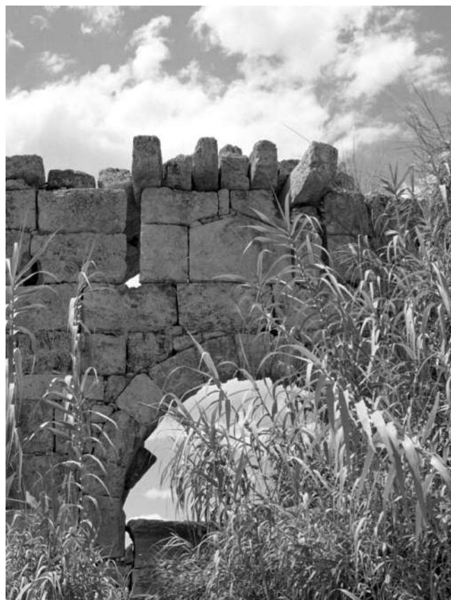
Илл. 7. Второстепенные восточные ворота в стенах нижнего города Перге. Над воротным проходом можно видеть четыре консоли, оставшиеся от машикуля-бретеши. Фотография К.С. Носова.
