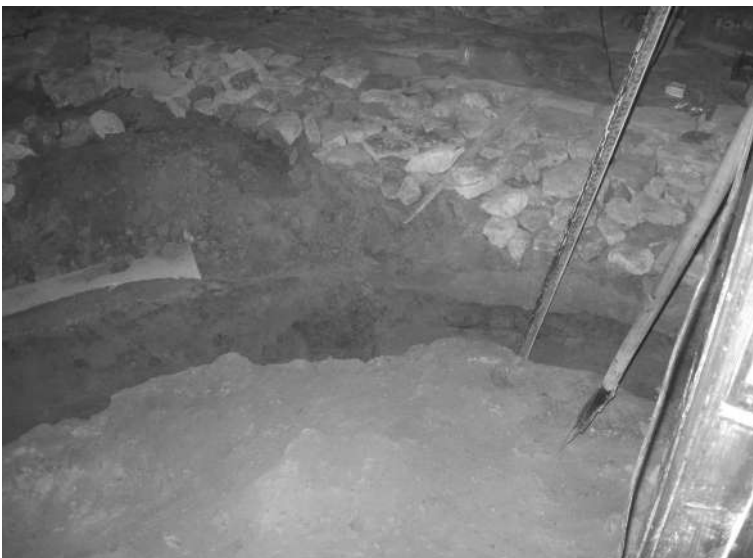
Фото 11. Півкруглий фундамент сходів
