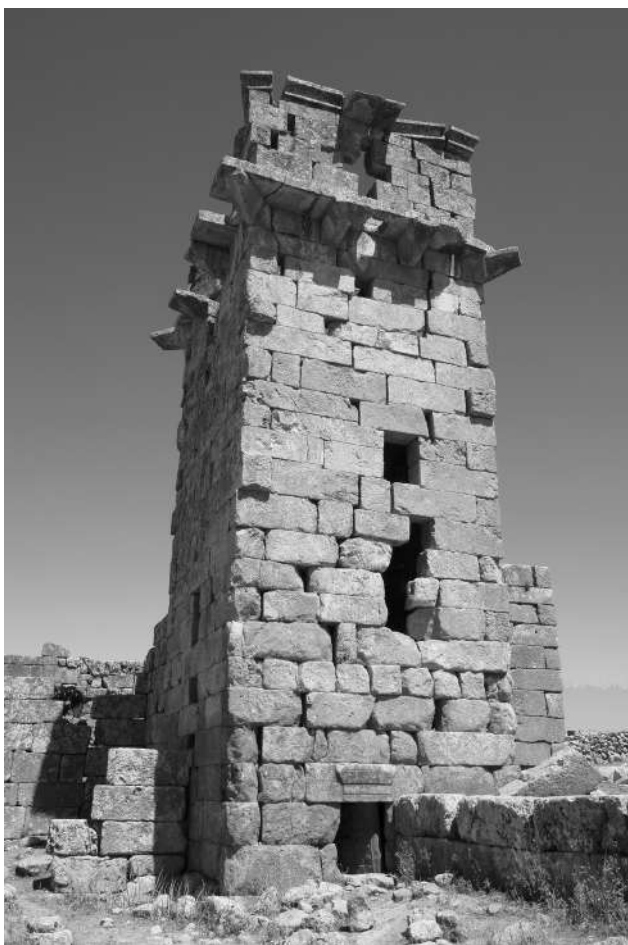
Илл. 4 и 5. Башня в Джераде и верхняя часть башни крупным планом. Хорошо видно круглое отверстие-машикуль в карнизе. V или VI в. н.э., Сирия. Фотографии К.С. Носова.
