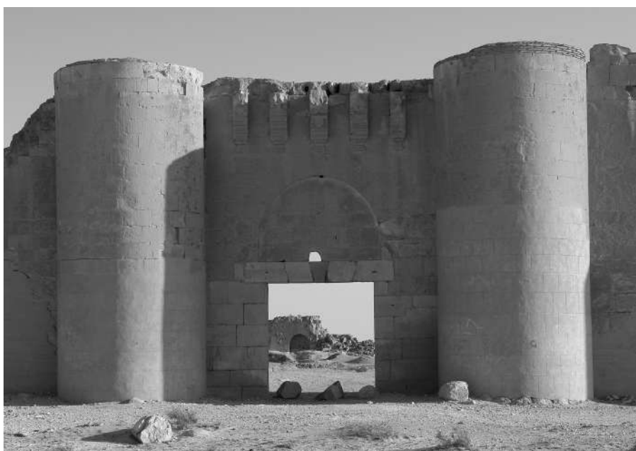
Илл. 1. Северные ворота большего сооружения в Каср аль-Хайр аль-Шарки. Видны консоли от машикуля-бретешеш. Фотография К.С. Носова.
