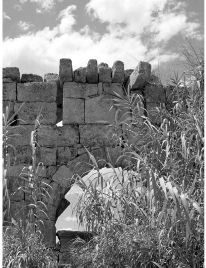
Илл. 7. Второстепенные восточные ворота в стенах нижнего города Перге. Над воротным проходом можно видеть четыре консоли, оставшиеся от машикуля-бретеши. Фотография К.С. Носова.
