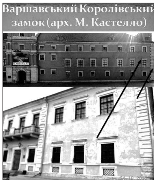
Фото 2. Бонування наріжників та обрамлення вікон Варшавського королівського та Збарзького замків (арх. М. Кастелло)
