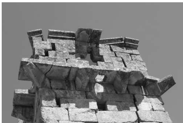
Илл. 4 и 5. Башня в Джераде и верхняя часть башни крупным планом. Хорошо видно круглое отверстие-машикуль в карнизе. V или VI в. н.э., Сирия. Фотографии К.С. Носова.
