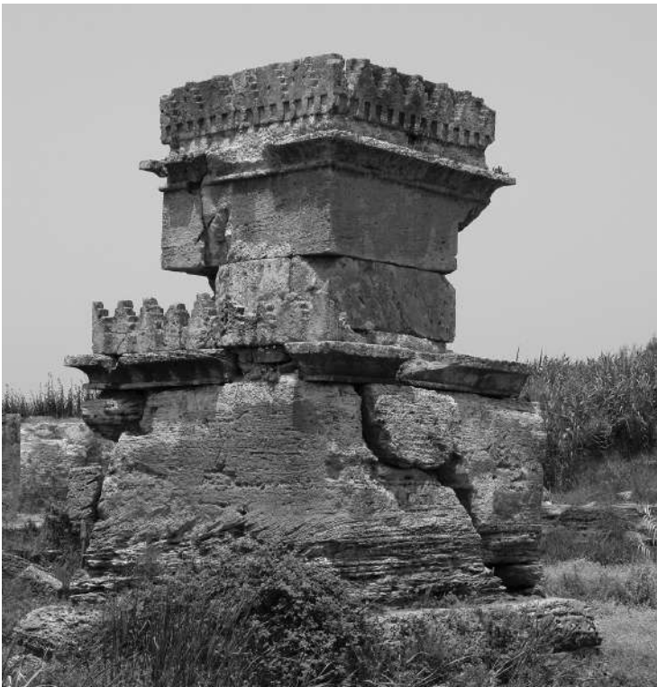
Илл. 8. Центральная башня ахеменидского храма конца VI в. до н.э. в Амрите, Сирия. Прекрасно видно оформление в виде ступенчатых зубцов и машикулей под парапетом. Фотография К.С. Носова.
