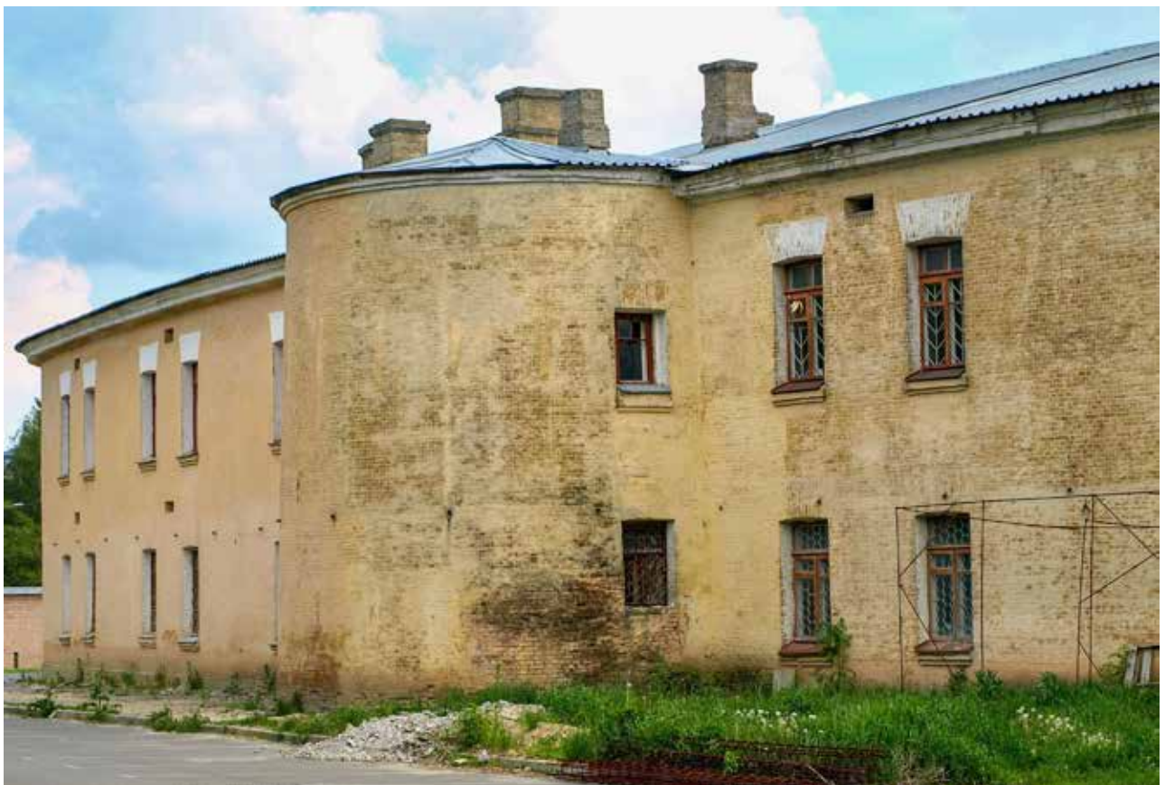
Рис. 6. Північна напівбашта Госпітального укріплення. Вигляд з півночі. Фото Андрія Швачка, 2008р.
