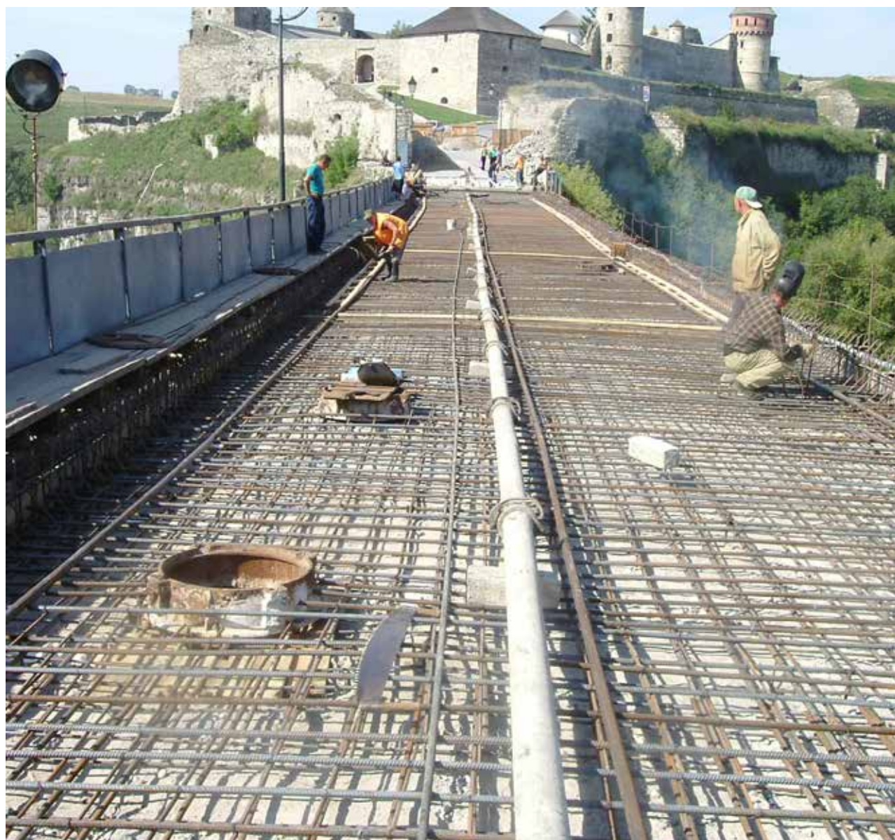
Рис. 2. Влаштування монолітної залізобетонної плити з виконанням гідроізоляції (2005 р.)
