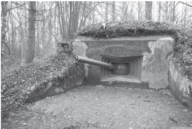
Рис.4. Внешний вид 85-мм казематной пушки ЗИФ-26, установленной вместо пушки Л-17 в процессе перевооружения в артиллерийском сооружении Карельского УРа. Фото с ресурса www.aroundspb.ru
