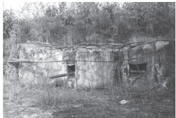
Рис.6. Артиллерийский полукапонир, построенный для 76,2-мм пушек обр. 1902 г. на лафетах обр. 1932 г., перевооруженный казематными 85-мм пушками ЗИФ-26. Дальний Восток. Фото Ю. Иванов (Владивосток)
