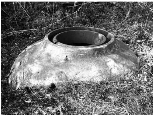
Фото 7. Верхня частина броньованого циліндра спостережного пункту Керешмезького вузла оборони.
