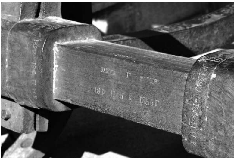
Рис. 10. Лафет Венгловского. Клейма, обозначающие, что лафет предназначен для 18-фунтовой пушки.
