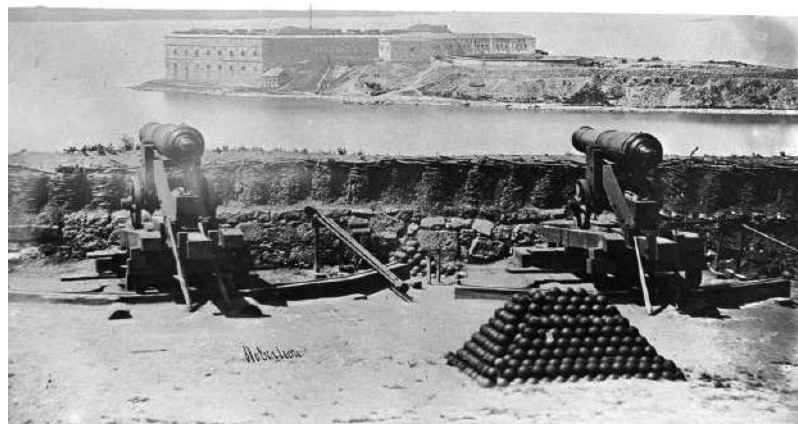
Рис. 6. Севастополь, Крымская война. Русская артиллерия на высоких крепостных лафетах, установленных на поворотных платформах.
