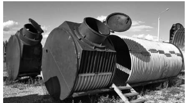
Мал. 1. Споруда для спостереження за допомогою перископів складена з комплекту КВС-У. Розріз (ліворуч) та загальний вигляд
